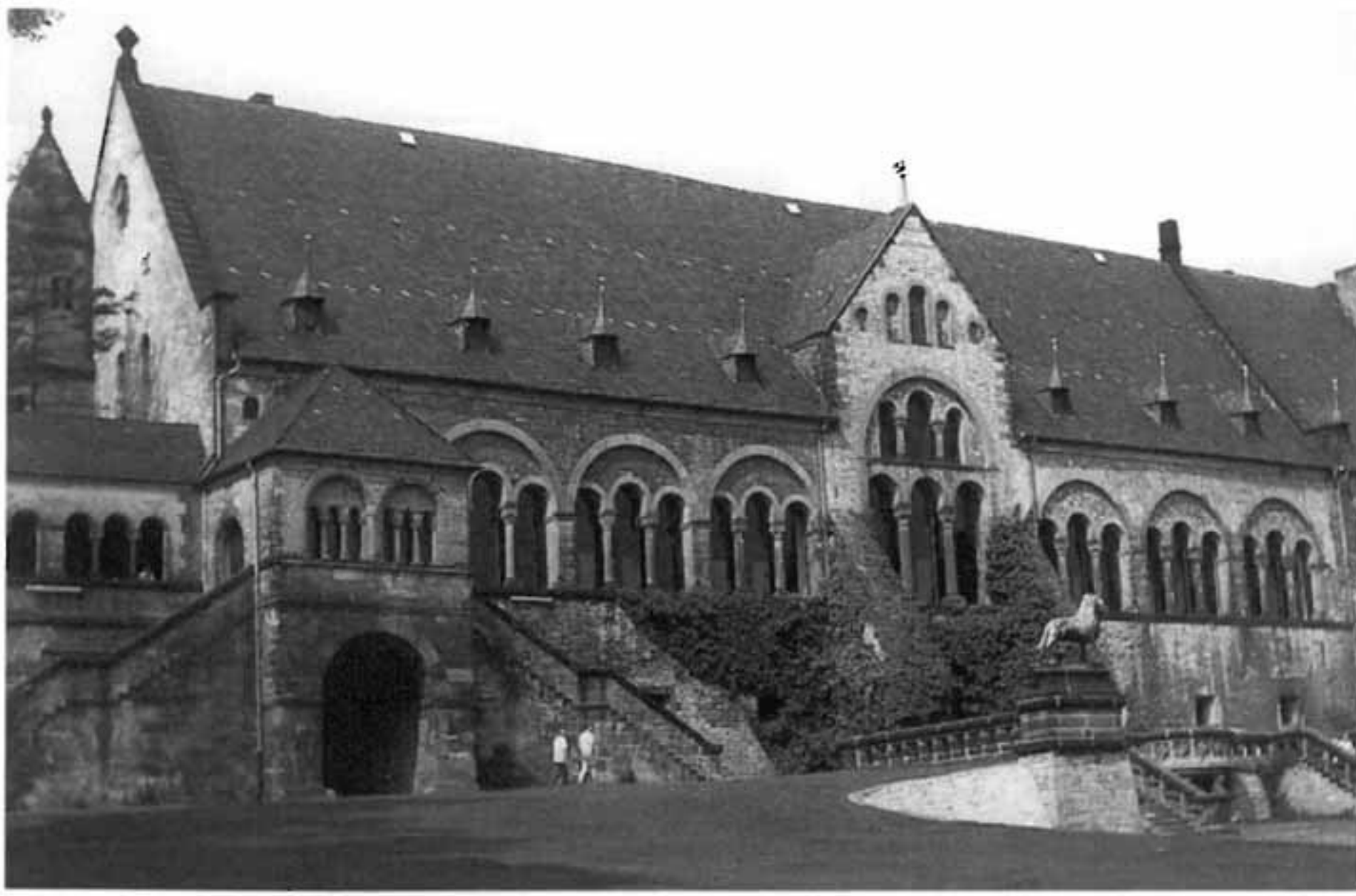
Abb. 20: Goslar. Kaiserhaus. Vorbau mit Treppen. (Photo: C. Meckseper 1968)
