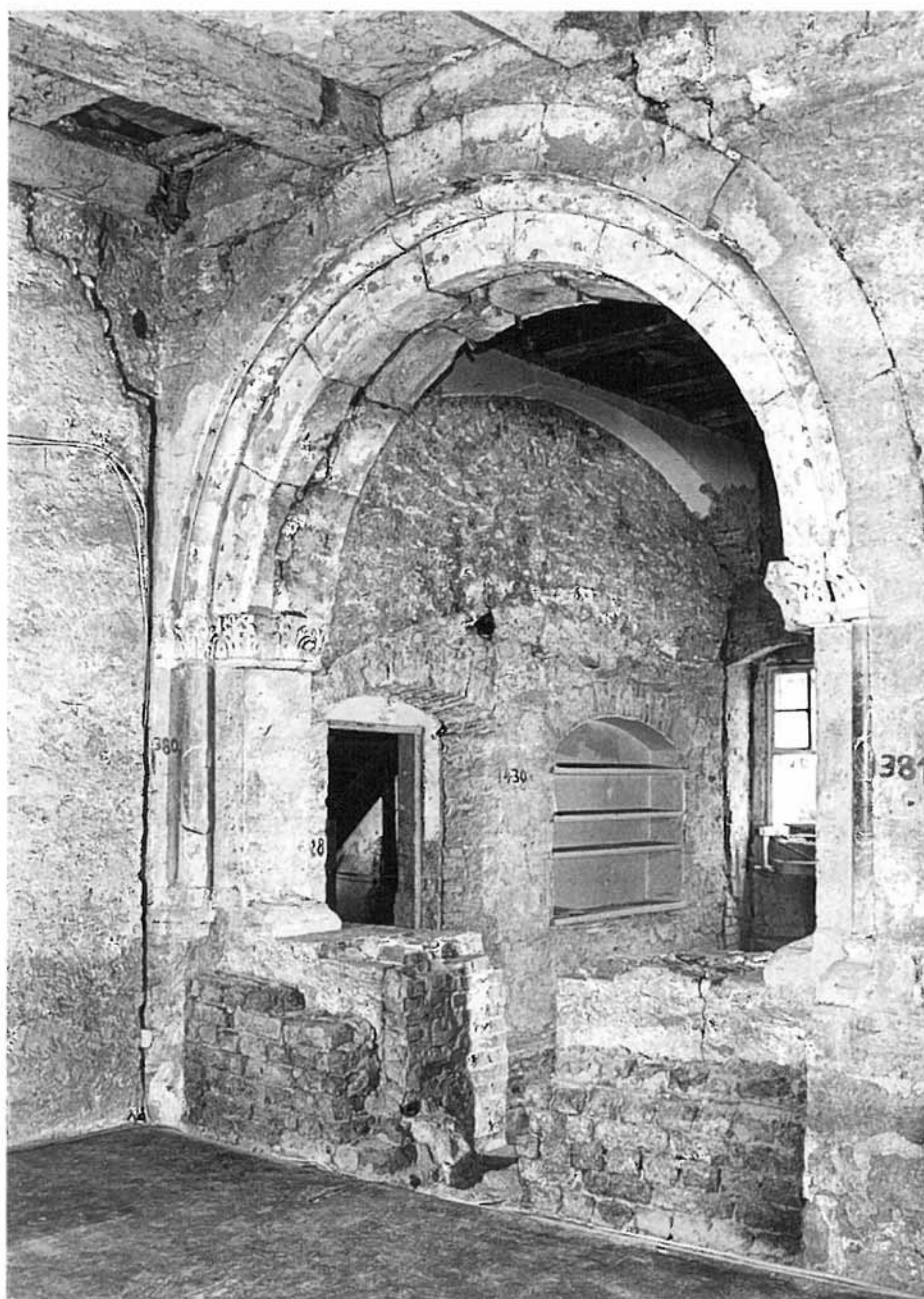
Abb. 16: Palasobergeschoß. Blick aus Raum 2.5 durch Fensterarkade in ehemaliges Treppenhaus (Raum 2.3). (Photo: P. Radtke 1993)
