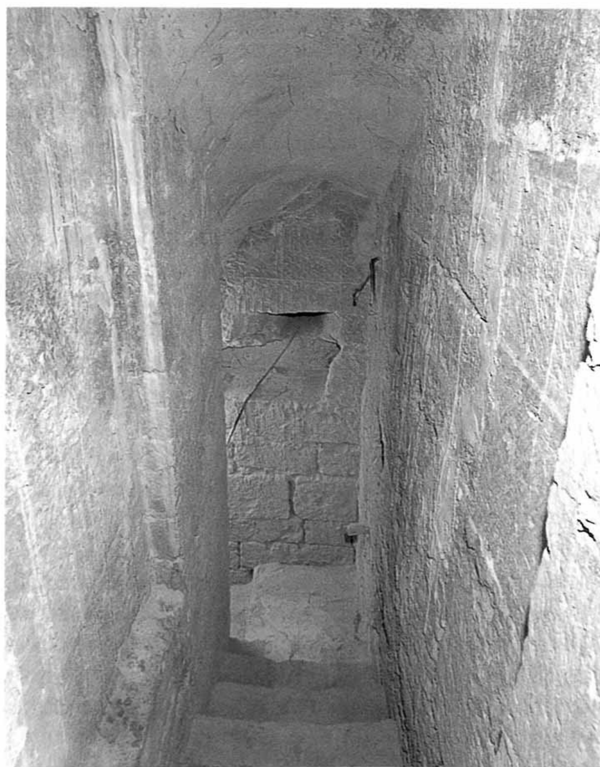
Abb. 14: Palasturm. Treppe in Mauerstärke mit Wölbung. (Photo: P. Radtke 1993)
