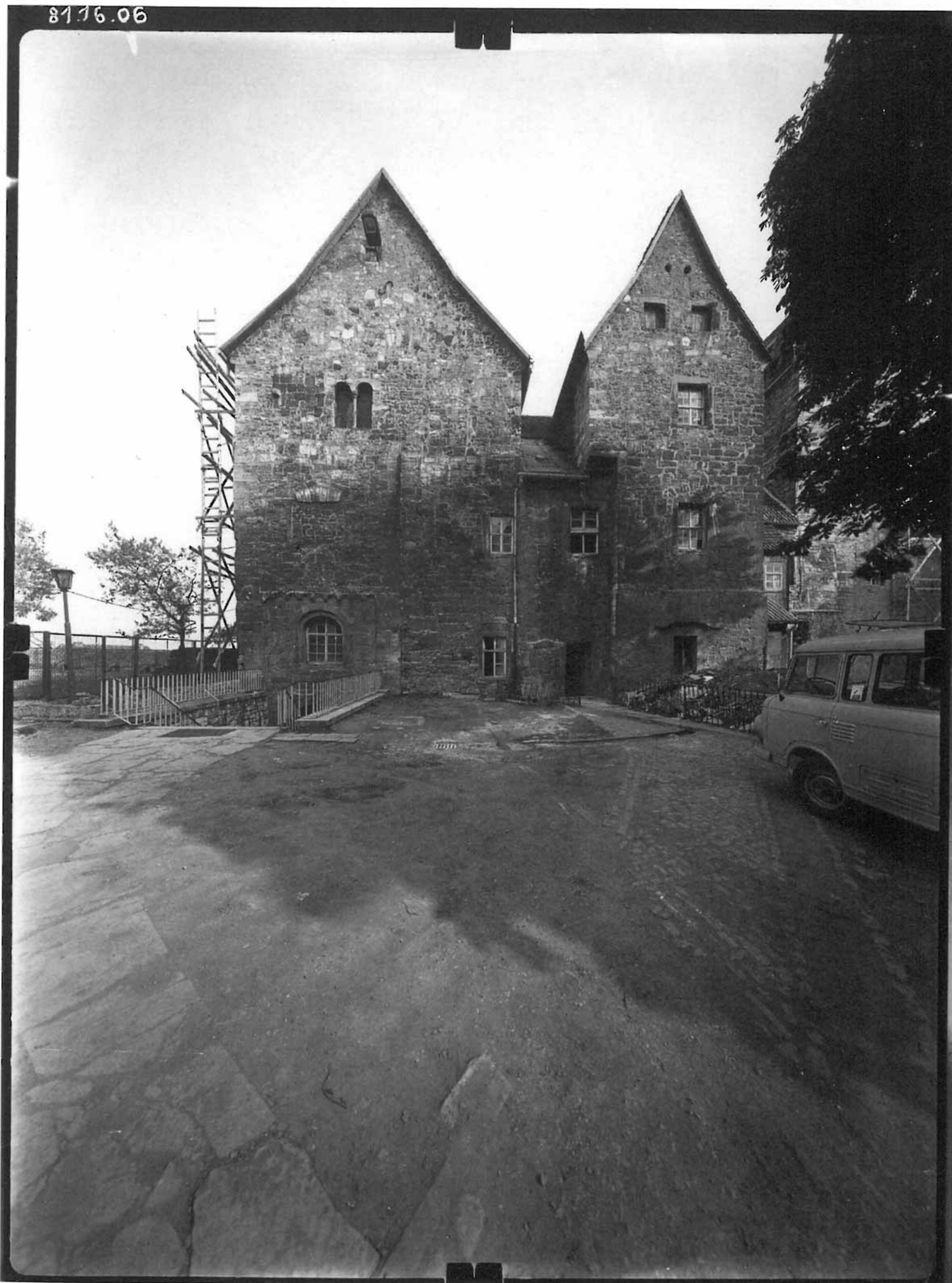
Abb. 5: Nord-Ost- und Nord- Westanbau des Palas zum Hof 1981. (Photo: Meßbildstelle GmbH Dresden 1981)
